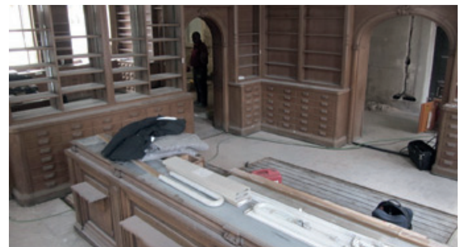
Juli 2014: Die ersten Umbaumaßnahmen haben dicke Staubschichten im ehemaligen Hauptraum der Apotheke hinterlassen.
